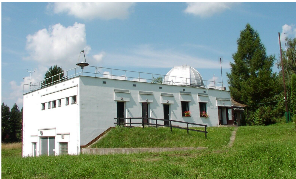
Obr. 4.1 Hlavní budova Hvězdárny v Úpici
